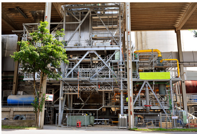
Wärmetauscher und ORC-Modul vor Einbringung der Turbine.
